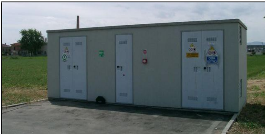
Fig. 2 - Esempi di cabina prefabbricata in fase di posa e ultimata
